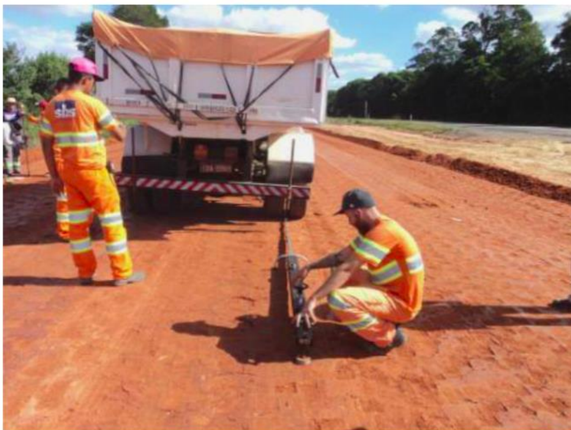
Figura 107: Ensaio viga Benkelman em campo
